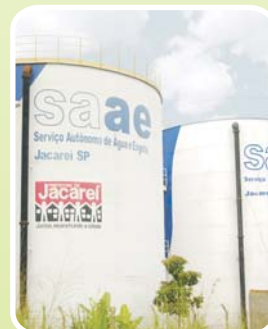
FOTO DOS RESERVATÓRIOS DE ÁGUA POTÁVEL
